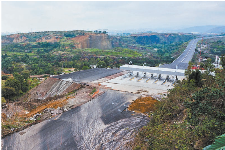
En varios tramos, la carretera Toluca-Naucaupan ya se encuentra trazada y revestida con cemento, e incluso está la estructura para caseta de cobro,
