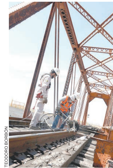
Personal de Ferromex trabajaba en reparar las vías en el puente del vertedor de la presa.
